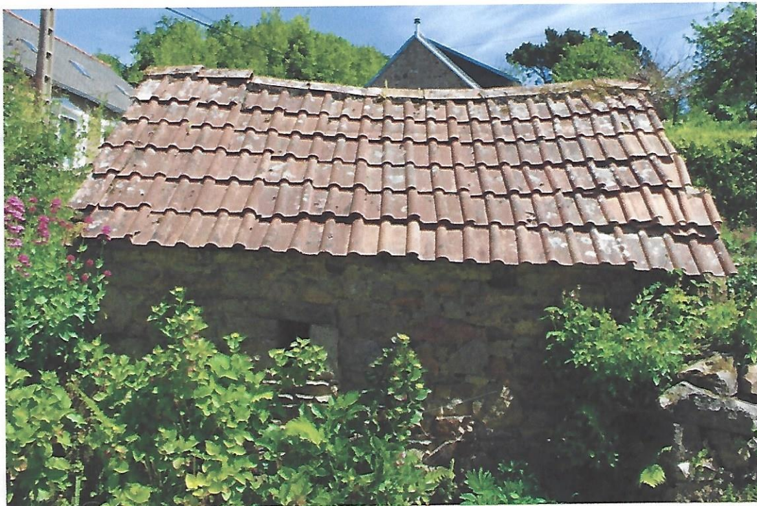
Une dépendance de ferme couverte avec des faitières et tuiles « anglaises » double romane.
