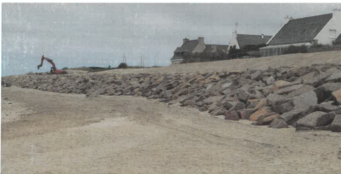
Ouvrage collectif protégeant sept maisons (TREGASTEL – Secteur de la Grève Rose)
