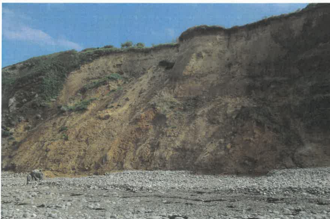
PLENEUF-VAL-ANDRE – Effondrement d'une falaise meuble
